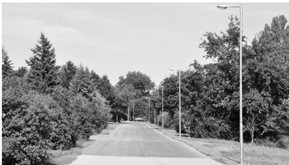
Elkészült a Vasút sor közvilágítási fejlesztése
