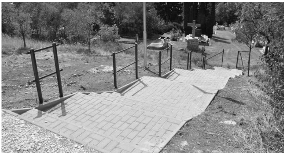
A temető északi kapujához vezető lépcsősor
